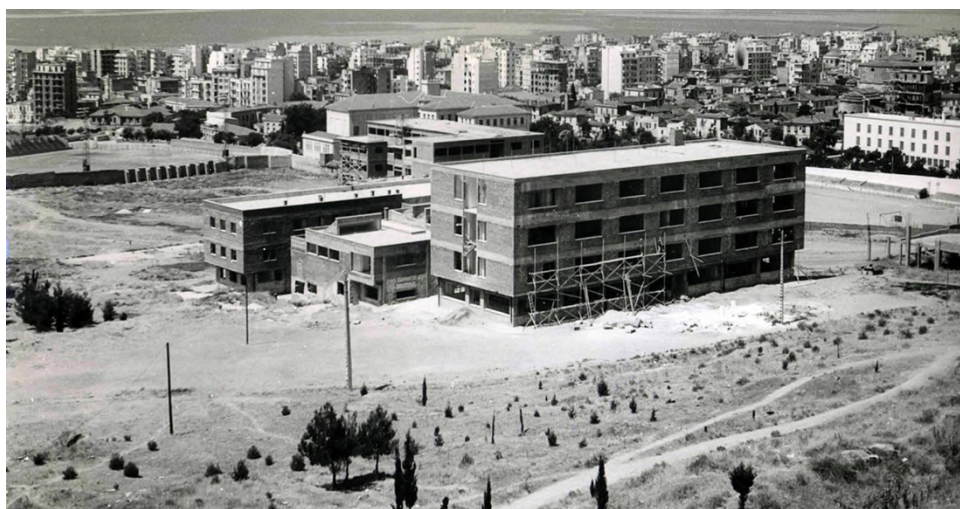
Εικόνα 2. Όψη του κτιρίου στο στάδιο της κατασκευής
